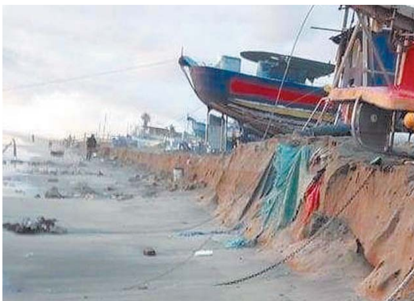
Torvaianica Anche qui la spiaggia non c'è più. Nella foto a destra la strage di cabine in uno stabilimento di Fregene
